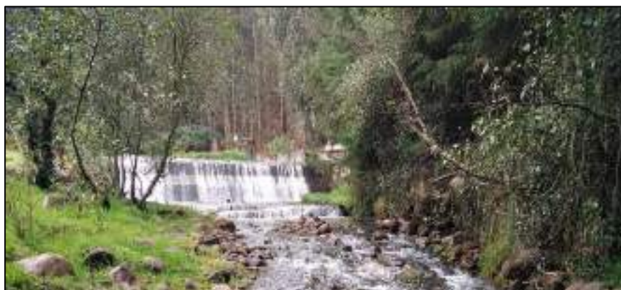
Figura 2. Erosión en el río Grande, aguas abajo de la captación Tres Molinos
