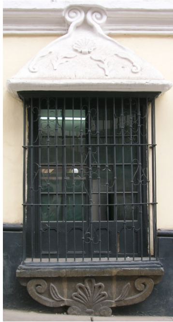
Monumento N° 33: Fotografía de la ventana del Jr. Cruz de Piedra N° 613
