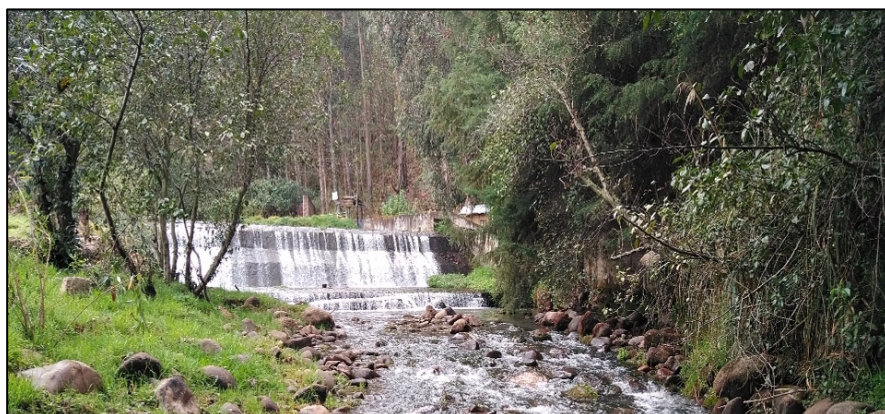
Figura 2. Erosión en el río Grande, aguas abajo de la captación Tres Molinos
